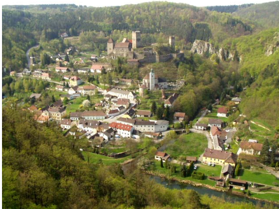
Blick von der Hardegger Warte auf Hardegger
