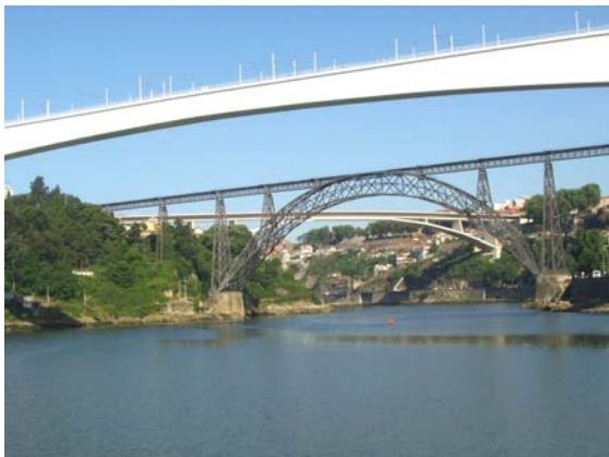
Neue u. alte (Eiffel-)Bahnbrücke, neue Straßenbrücke
