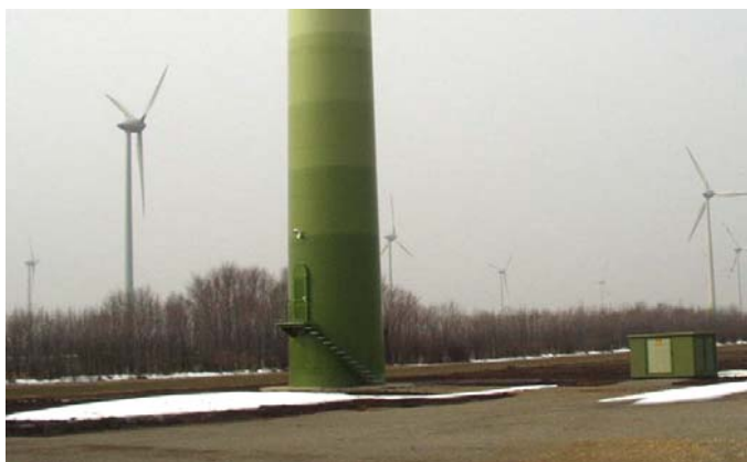
Turmfuß in Neusiedl nahe dem Grenzweg zu Weiden
