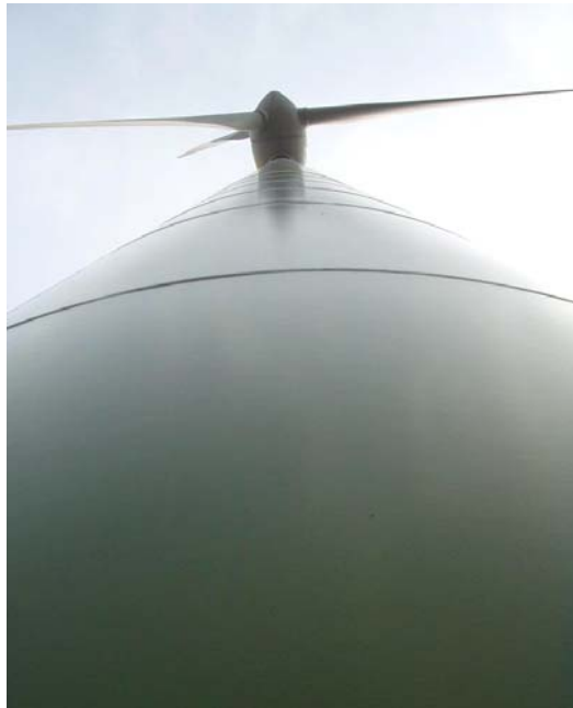
Der Mast als Turm; Nabenhöhe: 86m
